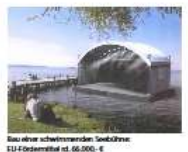
Bau einer schwimmenden Seehäute ILE-Fördermittel rd. 66.000,- €
